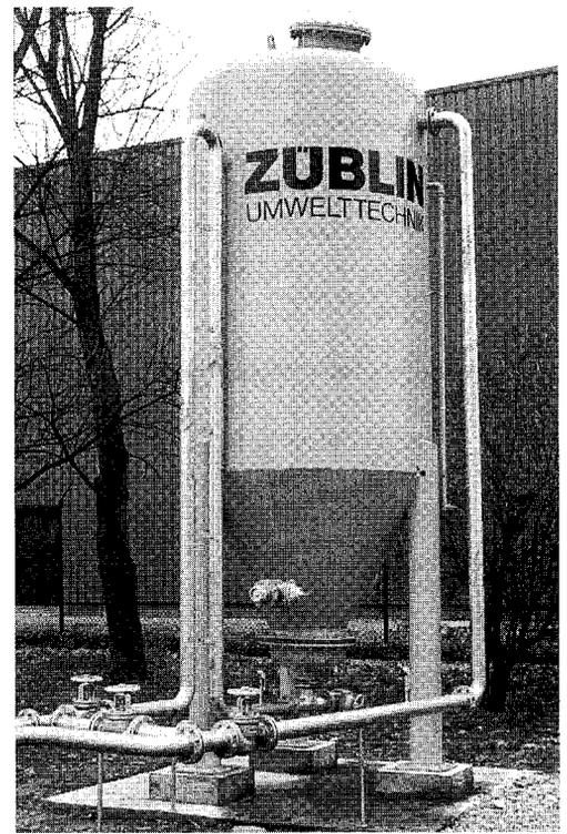
Bild 3. Wasseraktivkohlefilter mit  $10\text{ m}^3$  Nenninhalt
